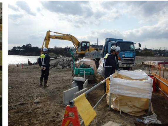
(写真：H28.2月 菖蒲田現場 社内安全衛生パトロール状況)
