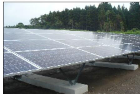
太陽光エネルギーを電気エネルギーに変換します。多結晶シリコン太陽電池を採用し、5,376枚を配置しました。
