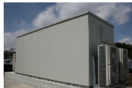
太陽光パネルからの直流電力を交流電力に変換する装置です。大容量500kWを3台設置しました。
