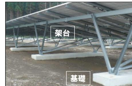
基礎は、置き式の基礎を採用し、造成後の状態で配置できるように配慮しています。架台は、支柱構造をV型にすることで、強度の確保と部材数・複合部数の低減を両立しました。
